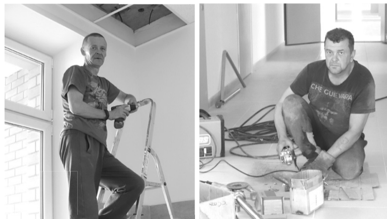
Завершающие работы в здании школы
